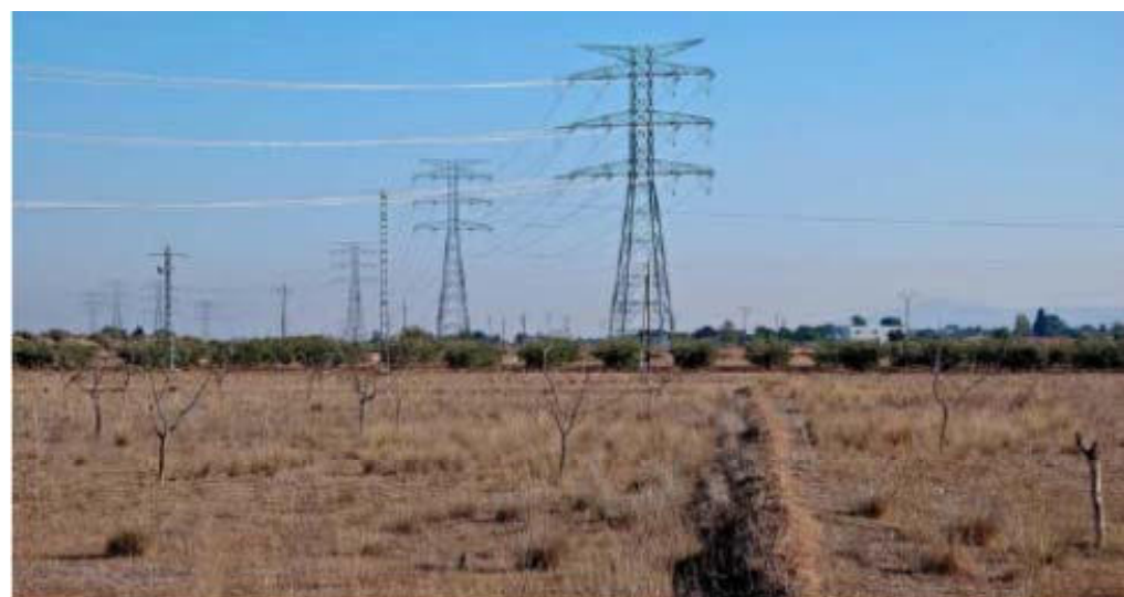
Imagen. Torre de Alta Tensión
