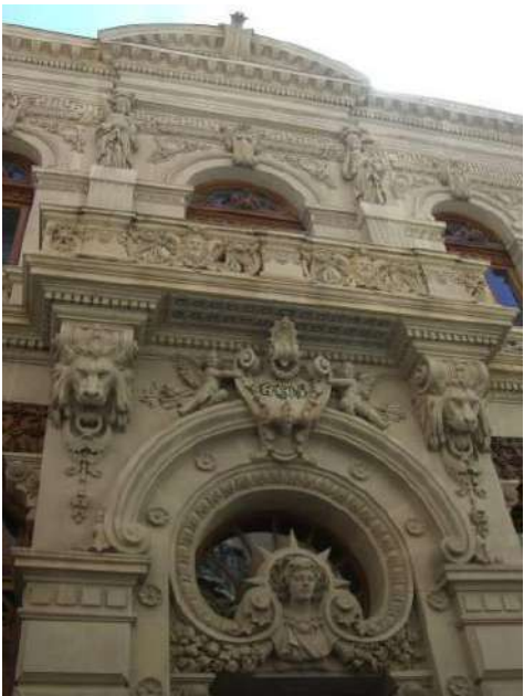
Figura 1.66. Casino de Murcia. (Fuente: Elaboración propia)
