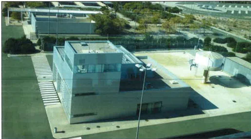
Imagen del edificio de protección y lucha contra incendios (SEI).
