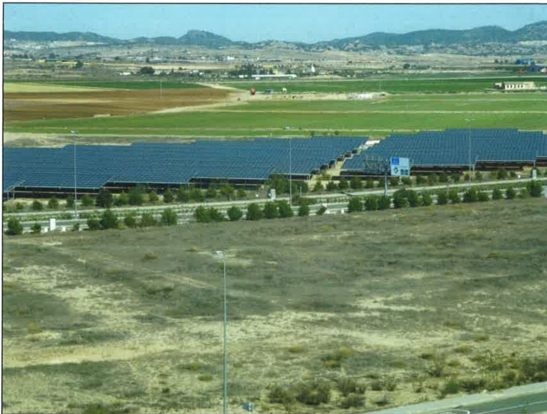
Imagen de parte de las parcela sin edificar del Subsistema de Actividades Aeroportuarias. Parcela de la Zona de Actividades Complementarias (SGA-ZAC-06).
