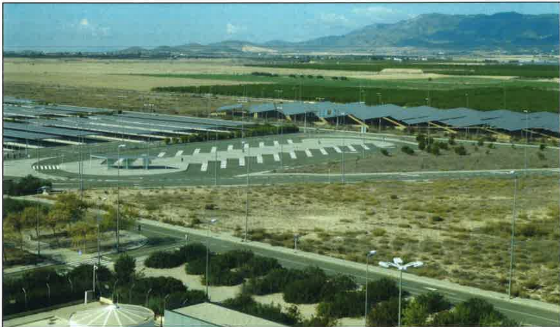
Imagen de parte de las parcela sin edificar del Subsistema de Actividades Aeroportuarias. Parcela de la Zona de Pasajeros (SGA-ZP-04).
