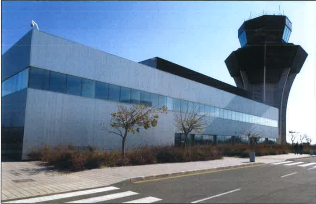
Imagen de la Torre de Control y Bloque Técnico.
