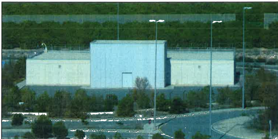
Imagen del depósito regulador de agua.
