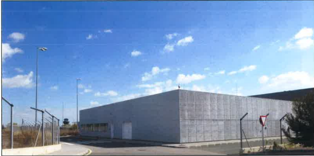
Imagen de la central eléctrica.
