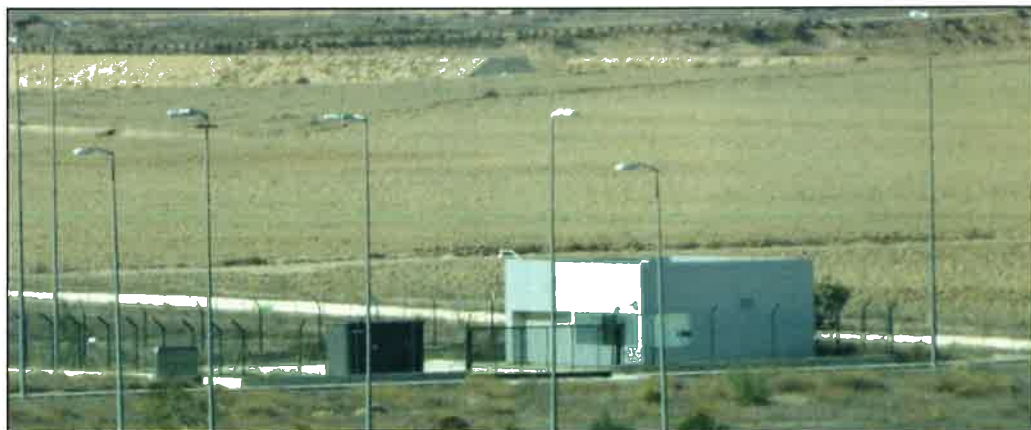
Imagen de la zona tratamiento de residuos. Punto limpio.
