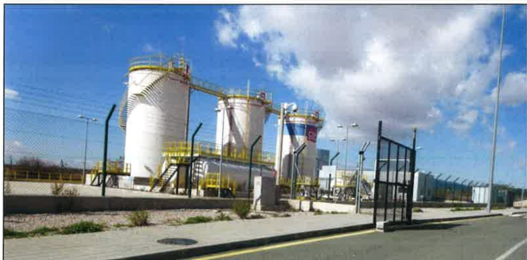
Imagen de los depósitos de combustibles. Parcela de combustibles
