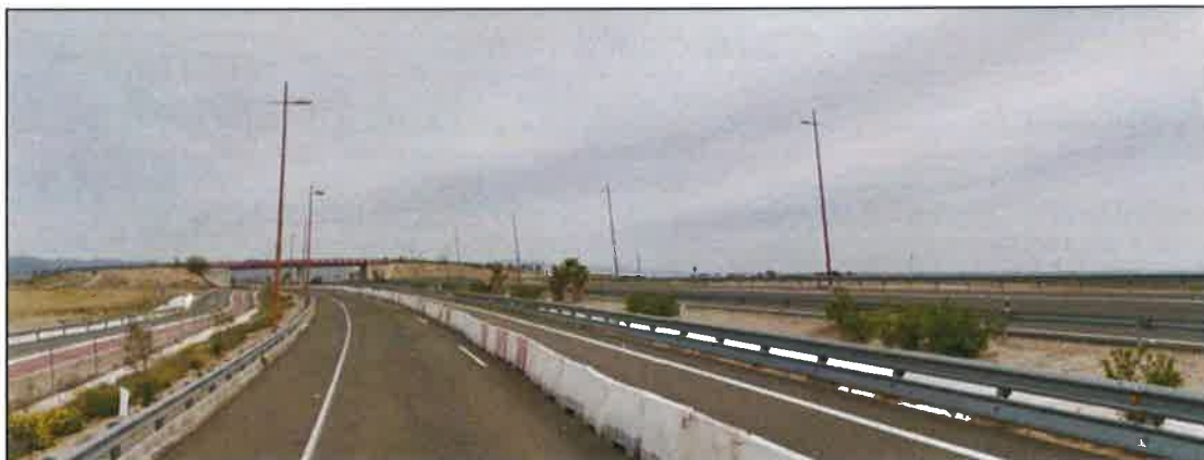
Acceso al Aeropuerto desde la Autovía A-30.
