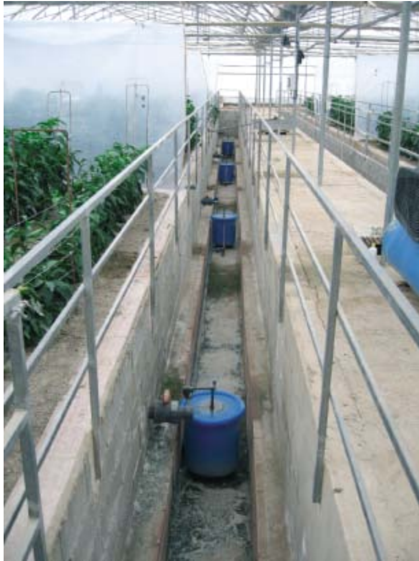
Foto 3 Foso de recogida de lixiviados y separación de las parcelas en cultivo ecológico, integrado y convencional.
