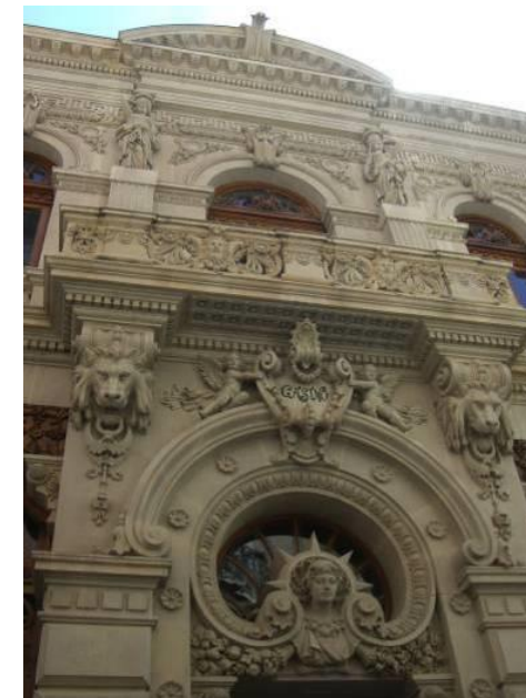
Figura 1.66. Casino de Murcia. (Fuente: Elaboración propia)
